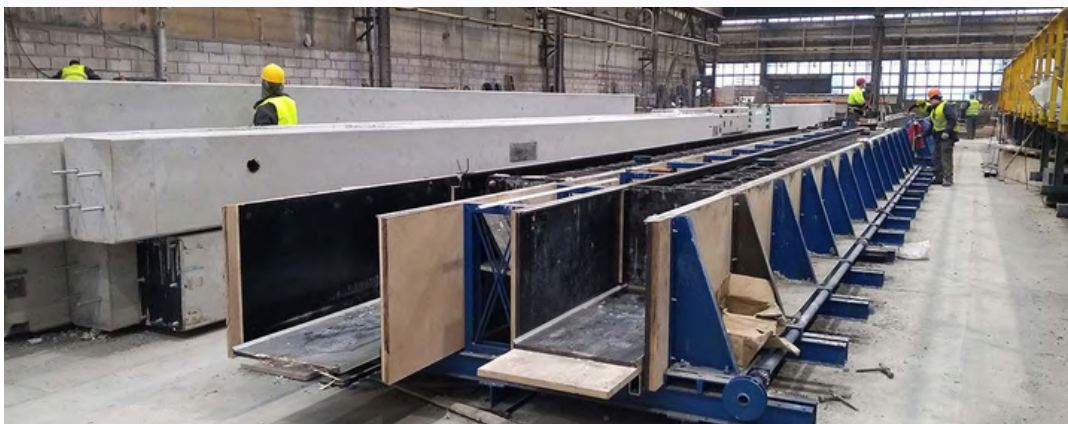
Beam formwork Forma do słupów
