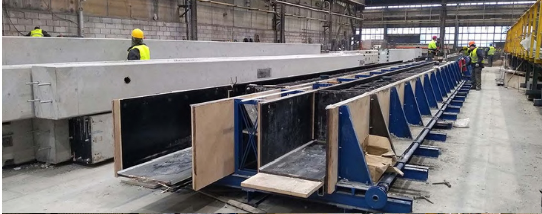
Beam formwork Forma do słupów
